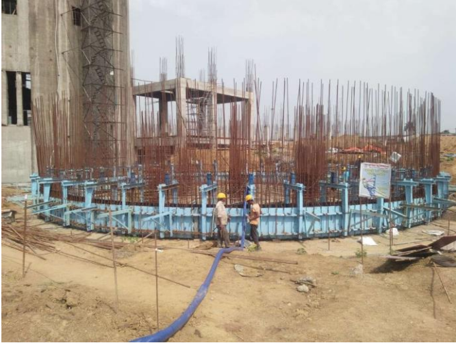
Fig: Slipform Erection for Silo
